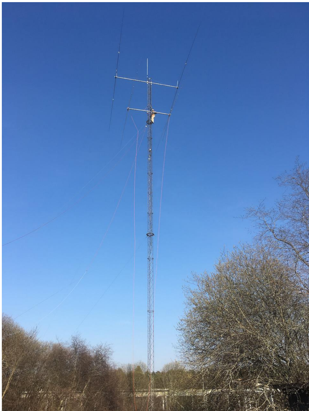
Kuvassa uuden 30m antennin asentaminen.
