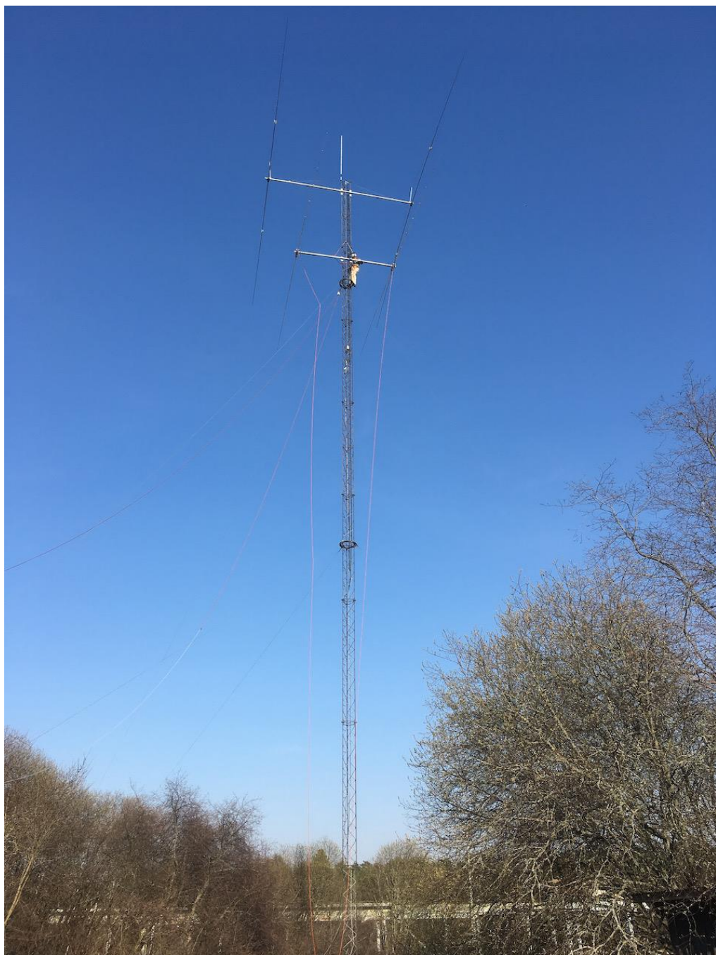
Kuvassa uuden 30m antennin asentaminen.
