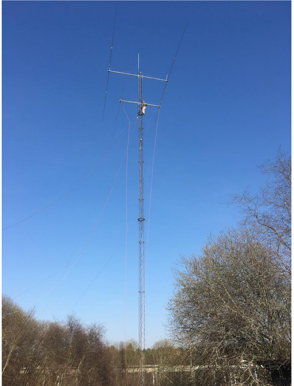
Kuvassa uuden 30m antennin asentaminen.
